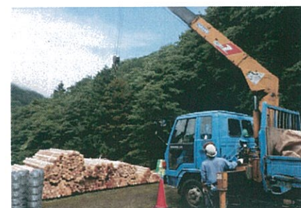
丸太筋工(運搬)
